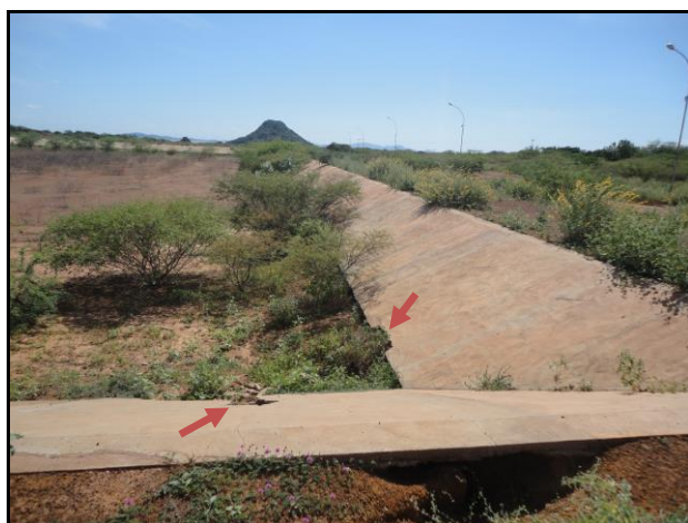
Figuras 17 e 18 – O processo erosivo causou o deslocamento da placa do talude (à direita) e a placa deslocada (à esquerda)
