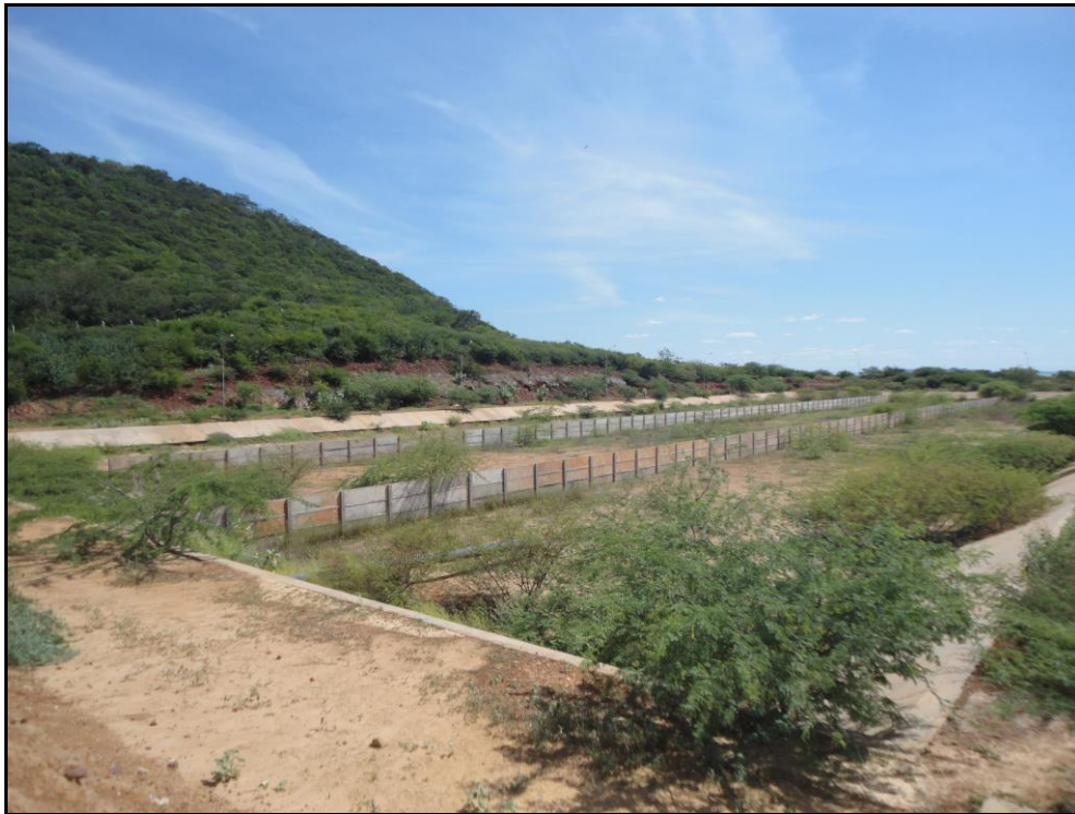
Figura 24 – Ausência de poda e limpeza nas Lagoas de Maturação
