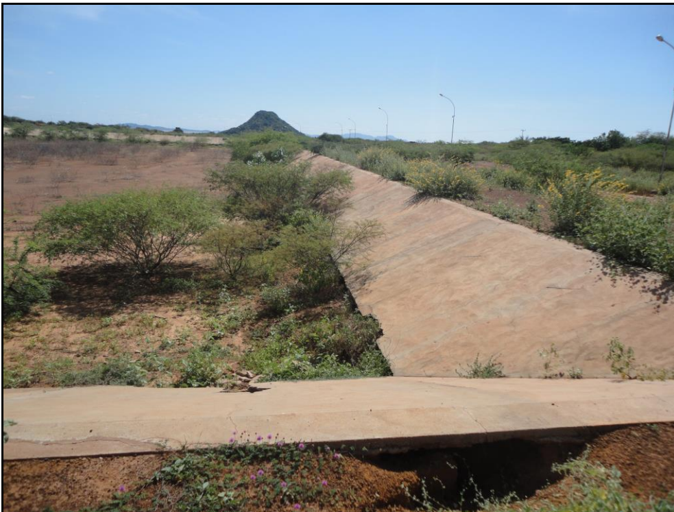
Figura 16 – Taludes da Lagoa Facultativa em concreto, com foco erosivo.
