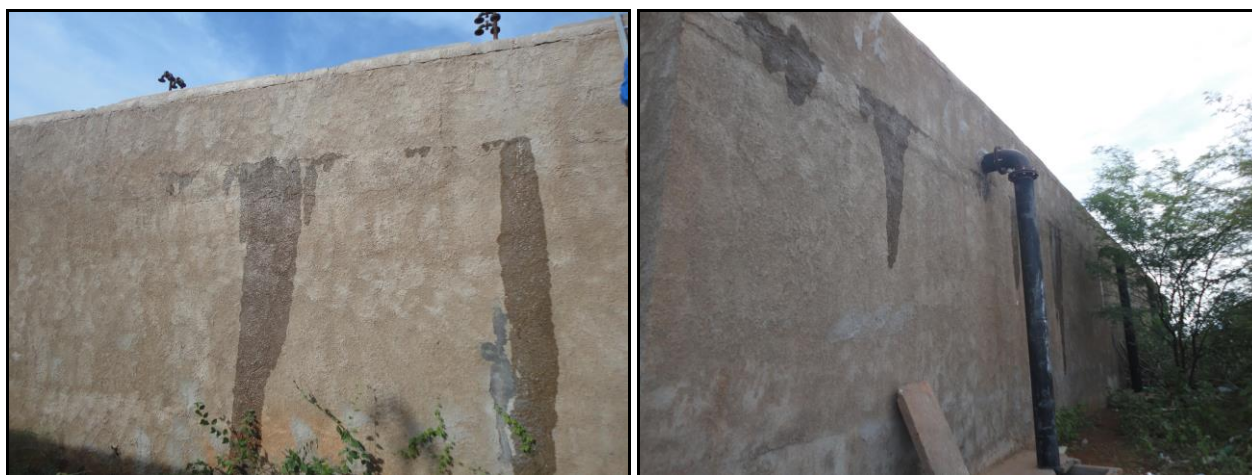
Figuras 44 e 45 – Demonstração das trincas de infiltração nos DAFA's durante o teste Hidráulico.
