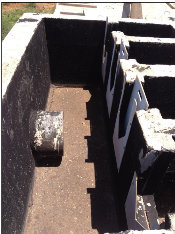
Figuras 03 e 04 – Entrada de esgoto no DAFA e comportas de distribuição do fluxo (à direita) e o separador de fases em fibra de vidro do DAFA
