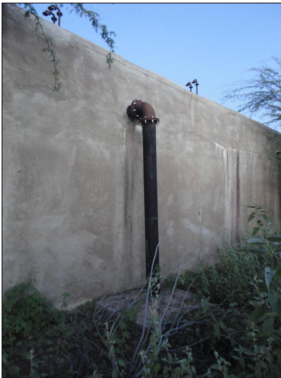
Figura 12 – Infiltração no DAFA
