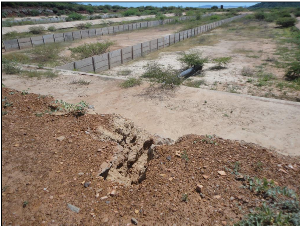
Figura 25 – Princípio de ravinamento no talude
