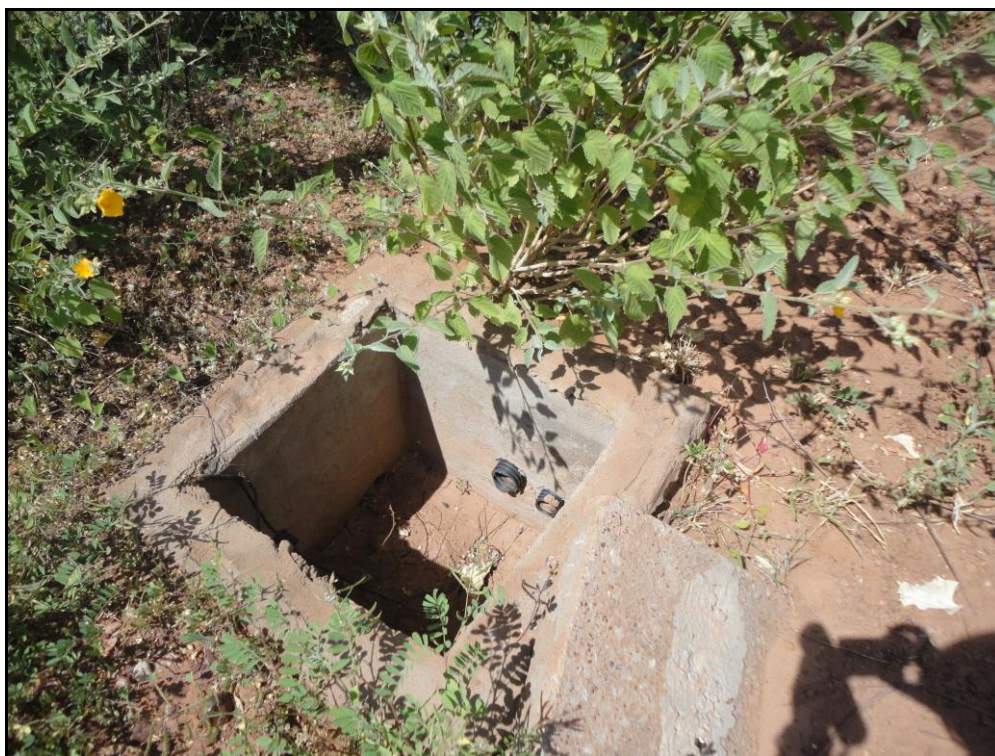
Figura 30 – Caixa de concreto com a ausência da fiação elétrica
