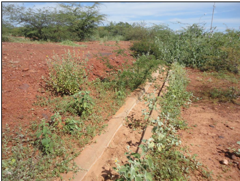
Figura 33 – Sistema de Drenagem obstruído por processos erosivos
