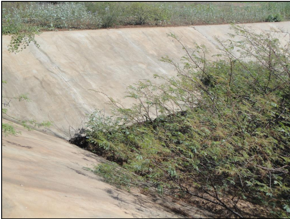
Figura 15 – Taludes da Lagoa Facultativa em concreto.
