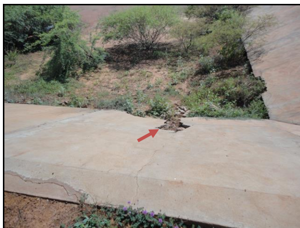
Figuras 17 e 18 – O processo erosivo causou o deslocamento da placa do talude (à direita) e a placa deslocada (à esquerda)
