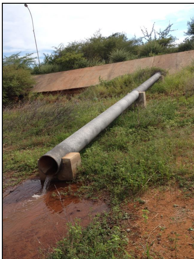
Figuras 50 e 51 – Execução do teste Hidráulico nas Lagoas
