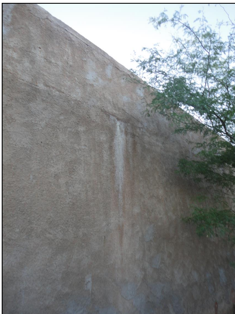
Figura 07 – Infiltração no DAFA
