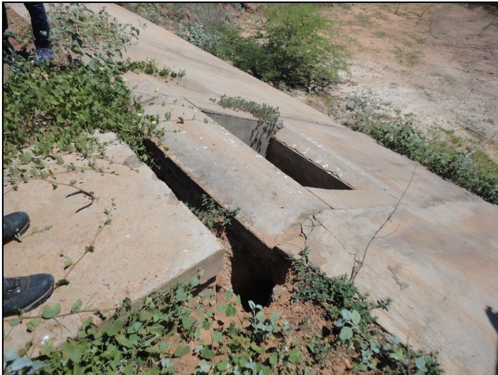
Figura 27 – Processo erosivo próximo à caixa de passagem entre a Lagoa Facultativa e a Lagoa de Maturação.
