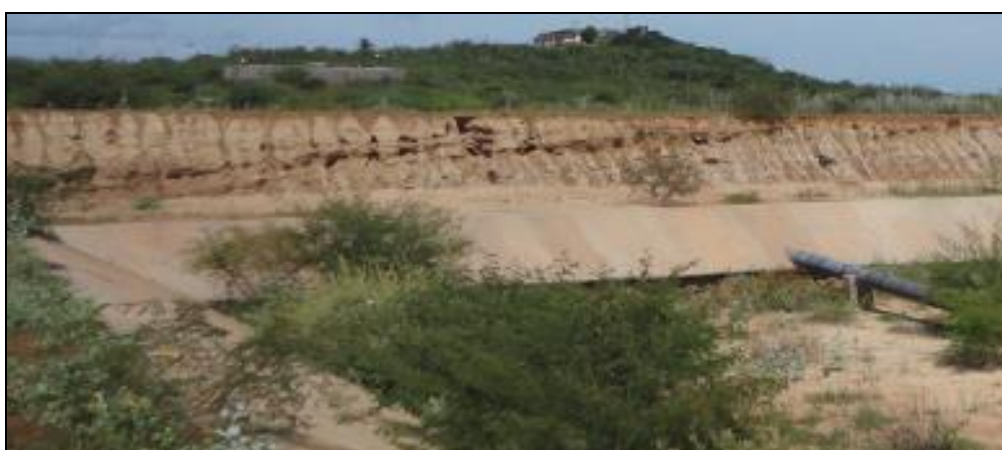
Figura 12 - Evidência de erosão em um dos taludes da ETE.
