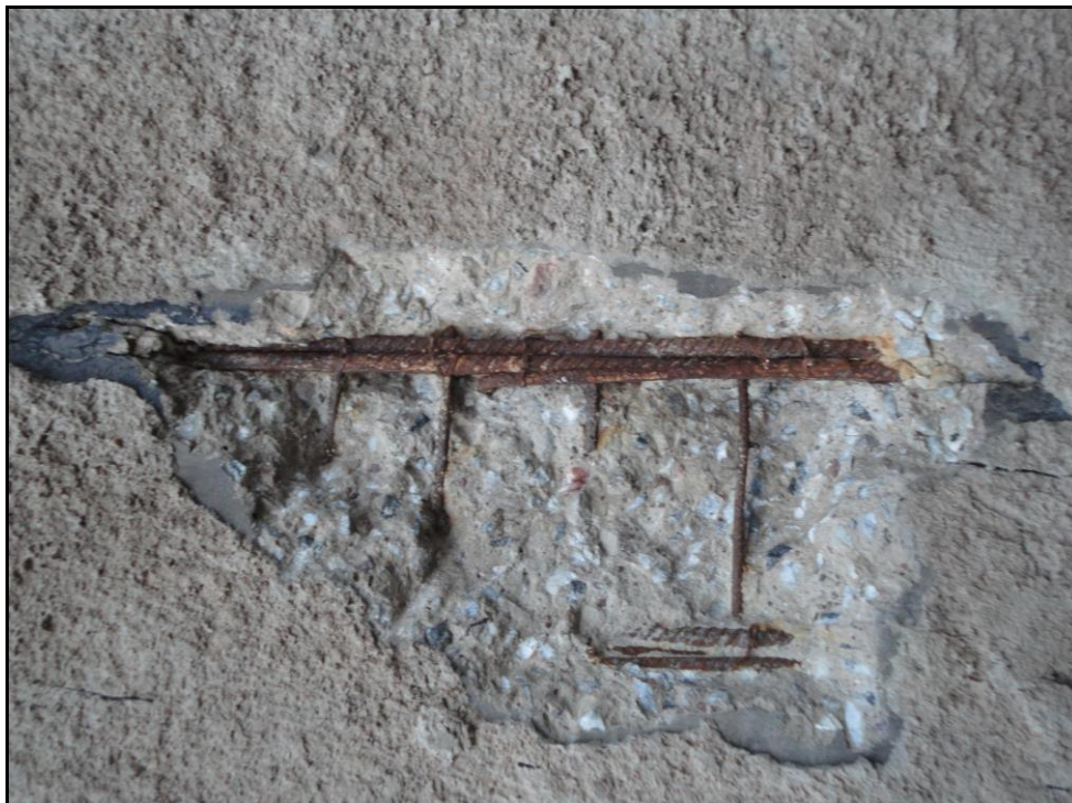
Figura 11 – Oxidação das ferragens, exposição dos agregados no DAFA
