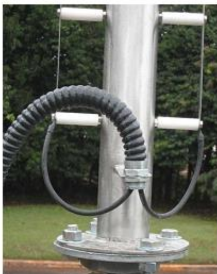
Figura 4 – Fixação do eletroduto flexível e cabos de velas
