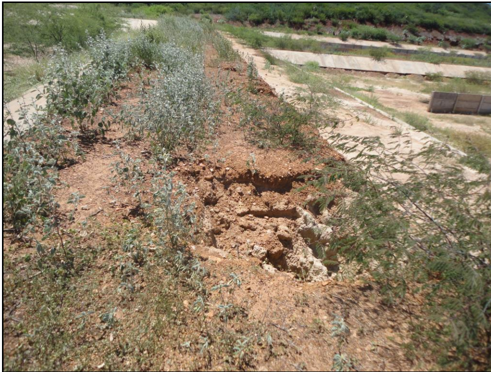
Figura 26 – Princípio de ravinamento no talude entre as Lagoas.
