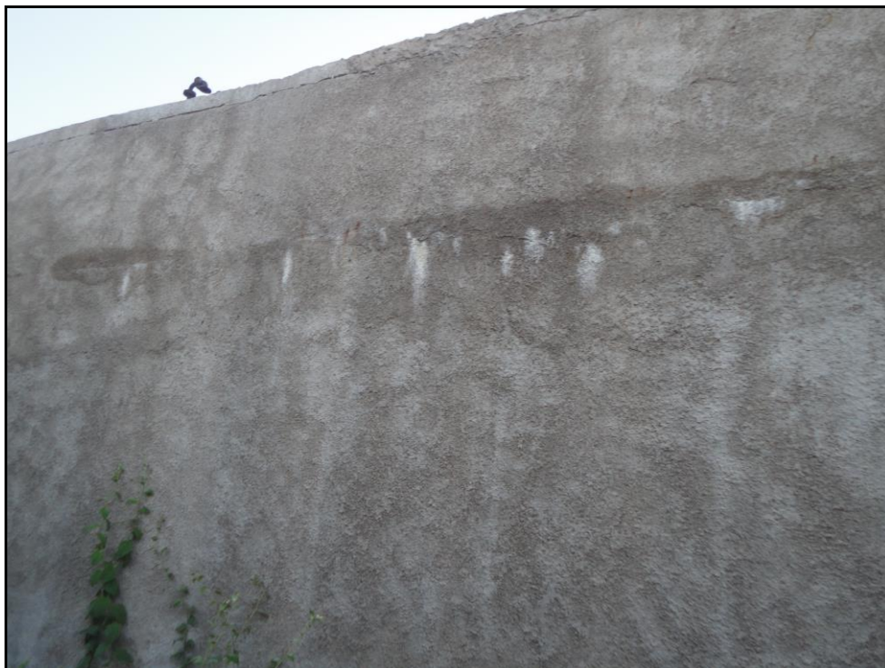
Figura 08 – Infiltração no DAFA
