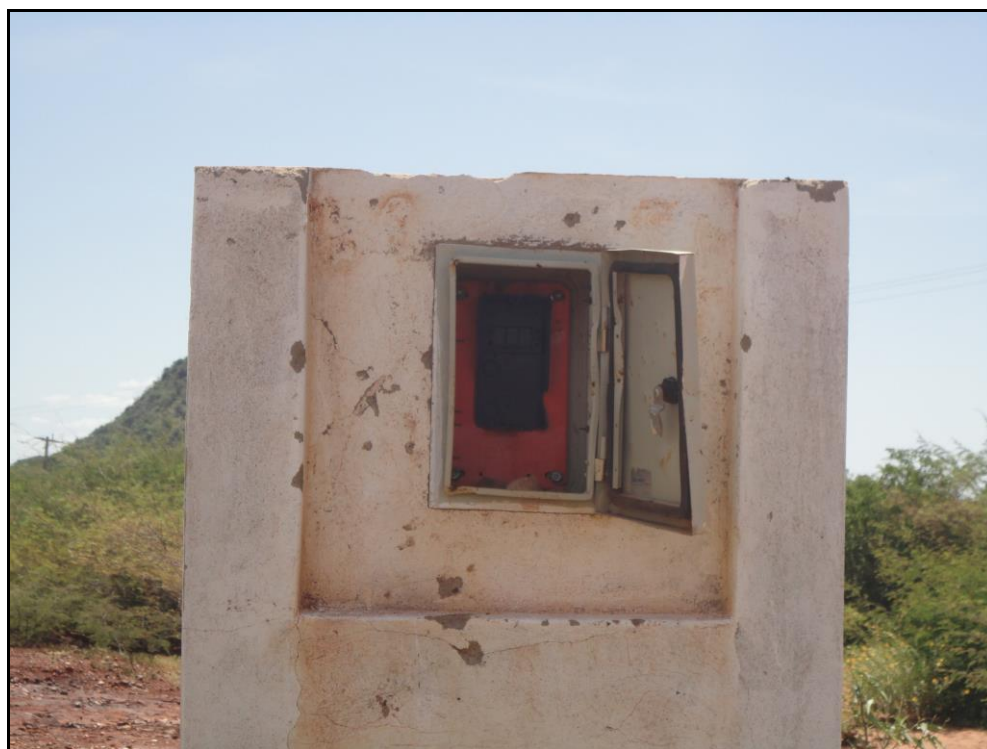
Figura 31 – Ausência do quadro de distribuição de energia do sistema de iluminação
