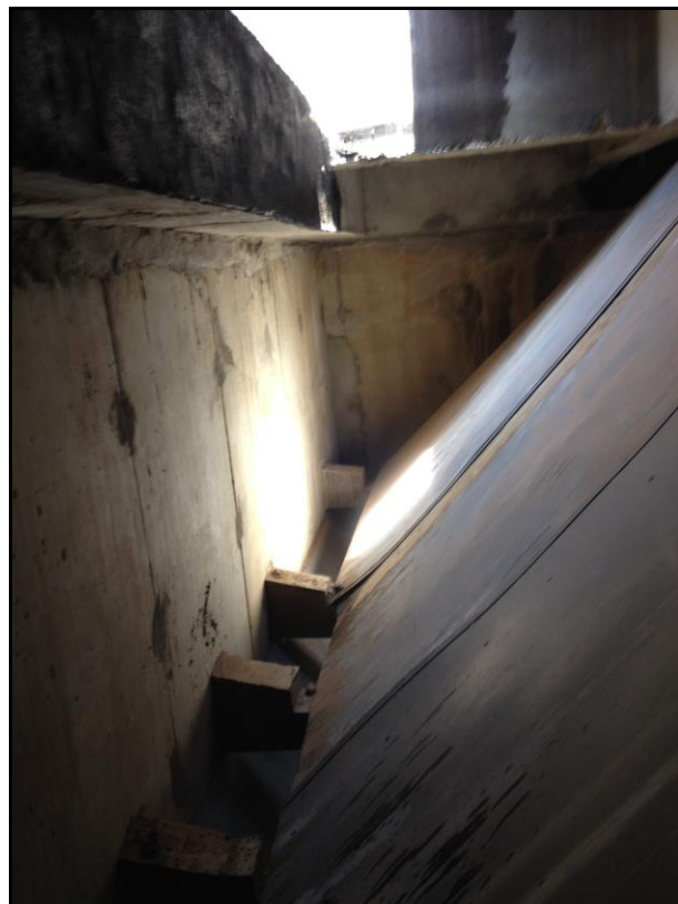
Figuras 03 e 04 – Entrada de esgoto no DAFA e comportas de distribuição do fluxo (à direita) e o separador de fases em fibra de vidro do DAFA
