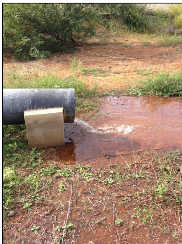
Figuras 50 e 51 – Execução do teste Hidráulico nas Lagoas
