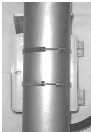
Figura 5 – Fixação da caixa do ignitor
