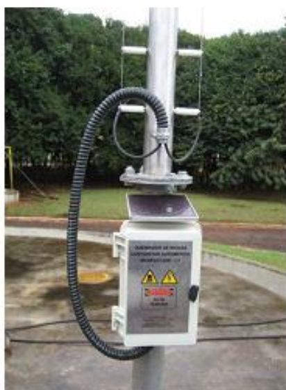
Figura 6 – Fixação do eletroduto flexível na caixa do ignitor
