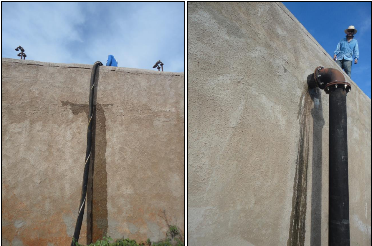
Figuras 46 e 47 – Demonstração das trincas de infiltração nos DAFA's, durante o teste Hidráulico.
