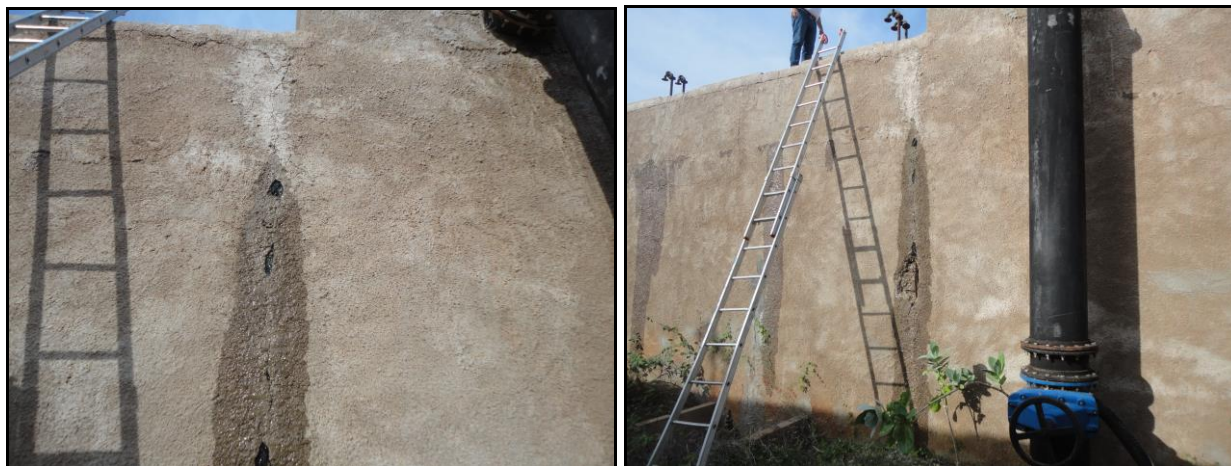
Figuras 42 e 43 – Demonstração das trincas de infiltração nos DAFA's durante o teste Hidráulico.
