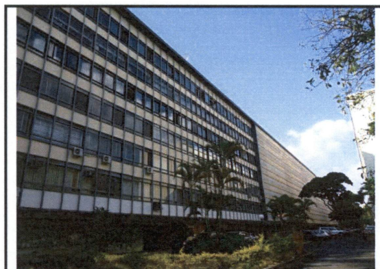
Foto 04 Fachada Leste (Lado Sul)
