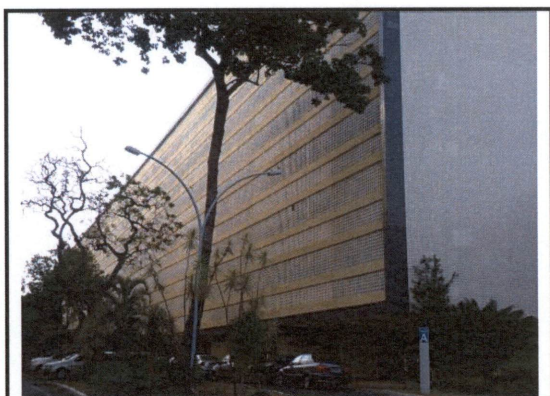
Foto 05 Fachada Leste (Lado Norte)
