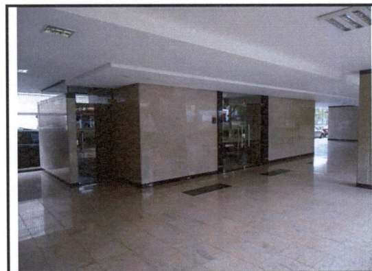
Foto 12 Pilotis – Entrada Prumada 05-06
