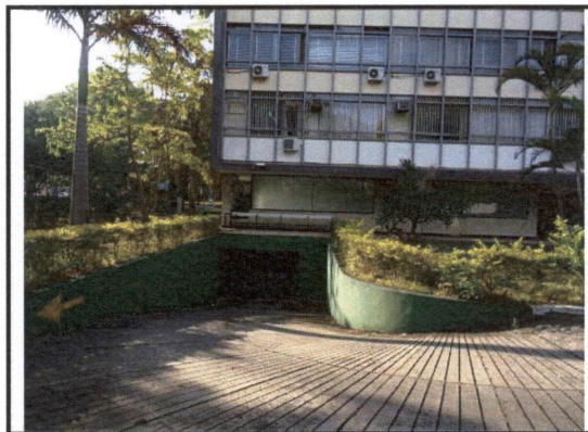
Foto 08 Saída Garagem (Lado Leste)
