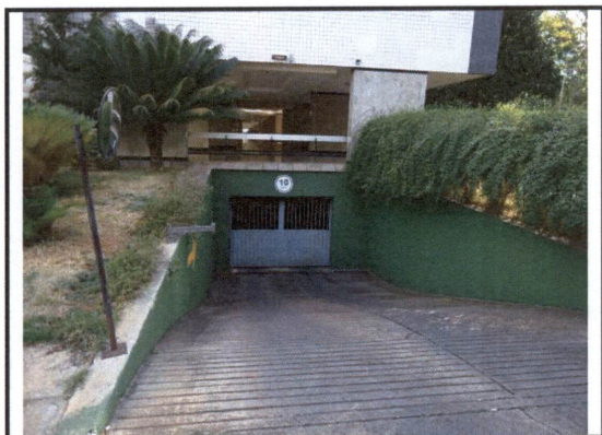
Foto 07 Entrada Garagem (Lado Norte)
