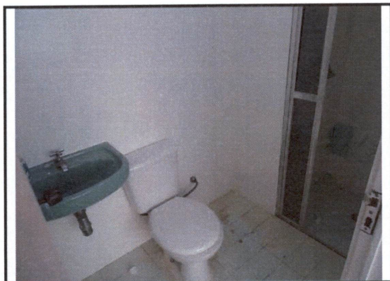
Foto 37 Apto. 103 – Banheiro de Serviço
