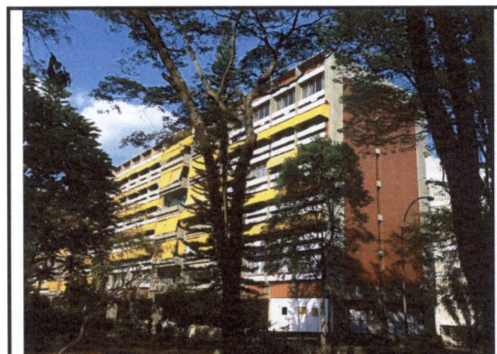
Foto 04 Fachada Oeste / Empena Sul
