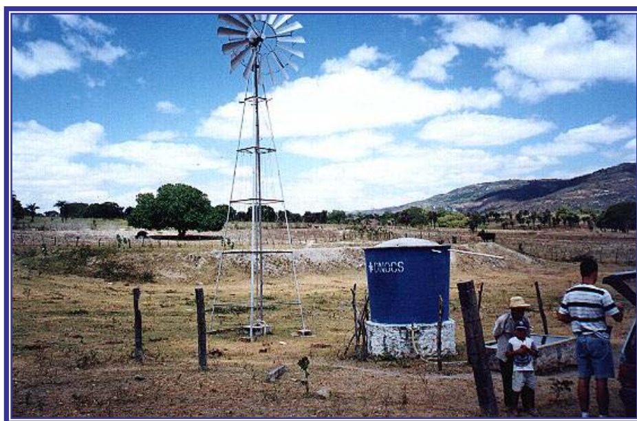
Foto 23 – Poço com bomba movida à energia eólica (cata-vento) no município de Dois Riachos (DR 01 P).
