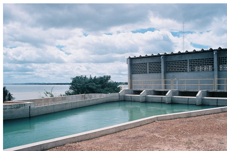
Estação de bombeamento do Projeto Pontal. É um exemplo de captação de água no rio São Francisco.
