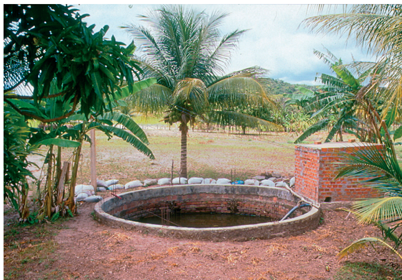
Cacimbão: poço profundo para retirar águas subterrâneas
