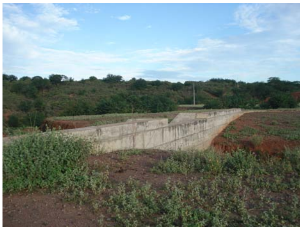
Fotografia 4 - Detalhe do sangradouro.
