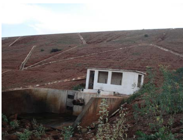
Fotografia 3 - Detalhe da tomada d'água.
