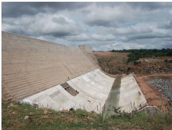
Fotografia 19 - Detalhe do sangradouro.
