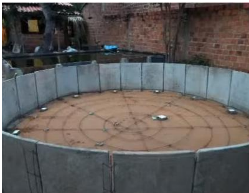
Figura 5: Demonstração da disposição das 24 placas.
