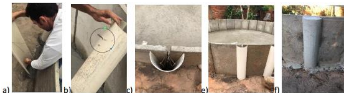
Figura 8: Demonstração da forma de PVC (200mm) para a união das placas.
