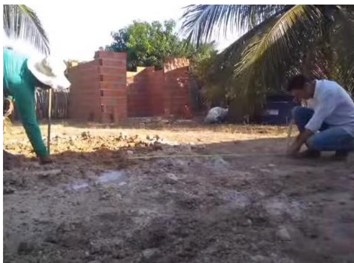
Figura 4: Demonstração da marcação do perímetro do tanque.
