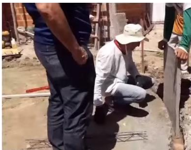
Figura 2: Demonstração da fixação das placas de concreto.
