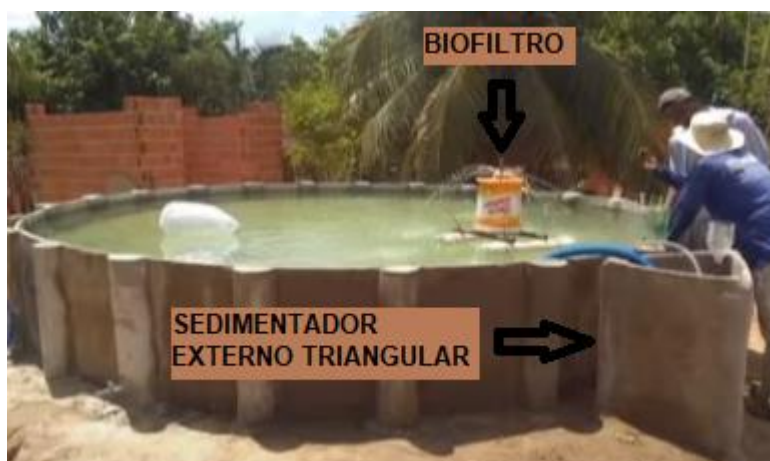
Figura 10: Demonstração do sedimentador e biofiltro.
