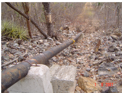
Trecho aéreo – AÇO USI SAC300
