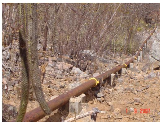
Trecho aéreo – AÇO USI SAC300
