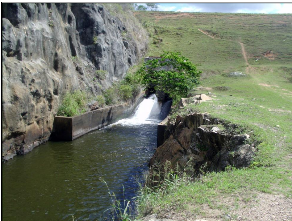
Figura 17 - Canal de Saída do Descarregador de Fundo
