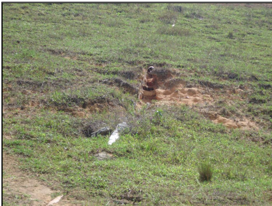
Figura 10 - Talude de Jusante - Erosões no talude e tubos de drenagem danificados e faltando
