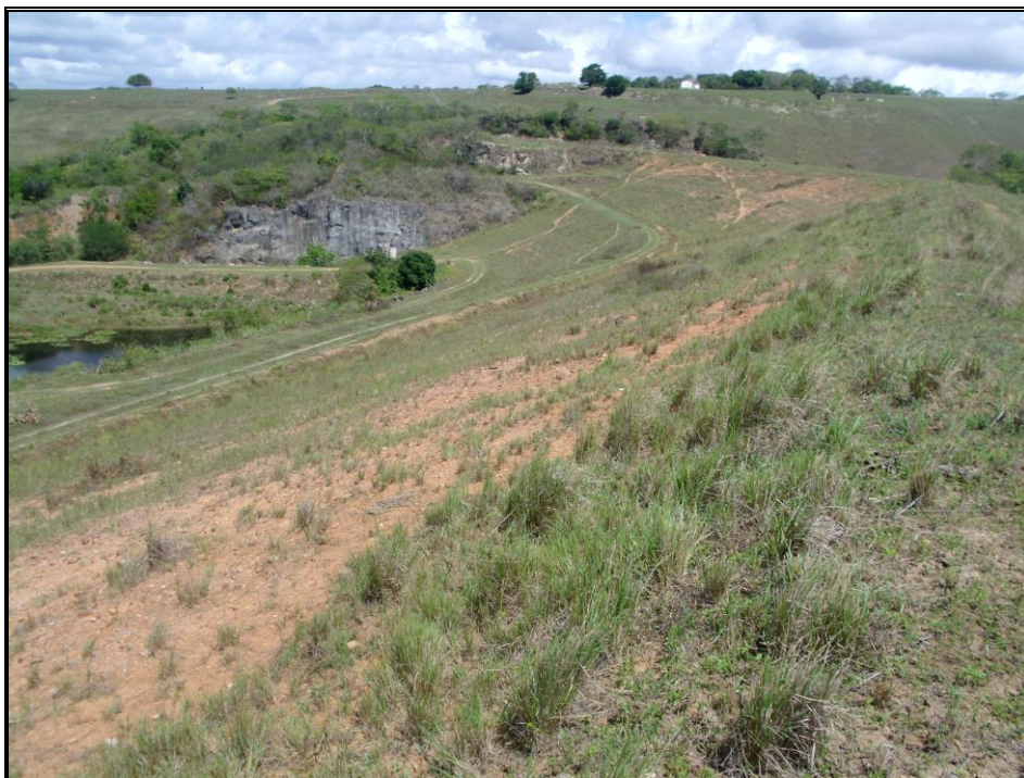
Figura 12 - Talude de Jusante - Bermas
