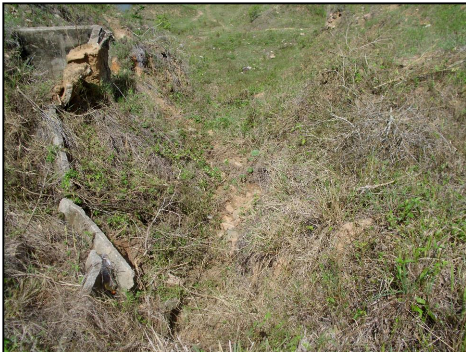
Figura 9 - Talude de Jusante - Erosões e rompimento de canaletas de drenagem
