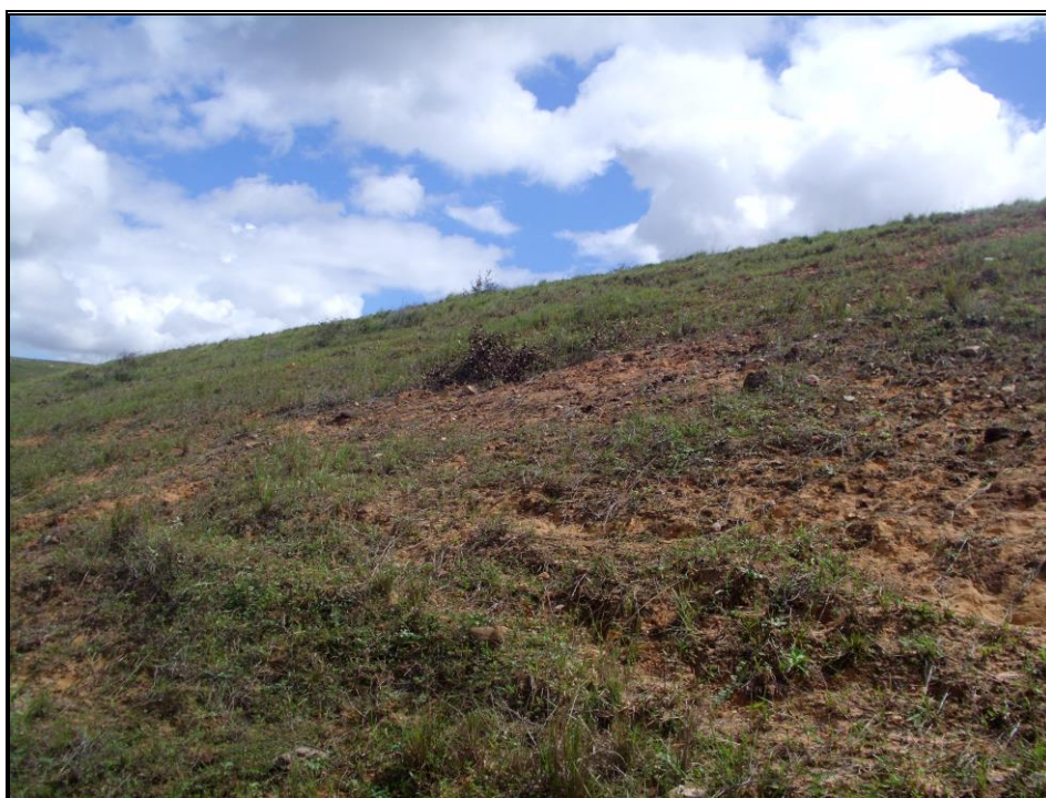
Figura 11 - Talude de Jusante - Falhas na proteção vegetal
