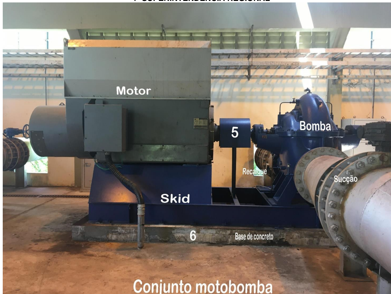
Figura Ilustrativa 02 – conjunto motobomba existente
