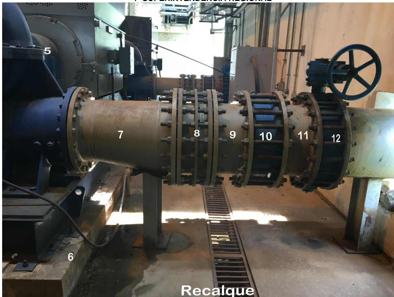
Foto Ilustrativa 03 – tubulação de recalque existente
