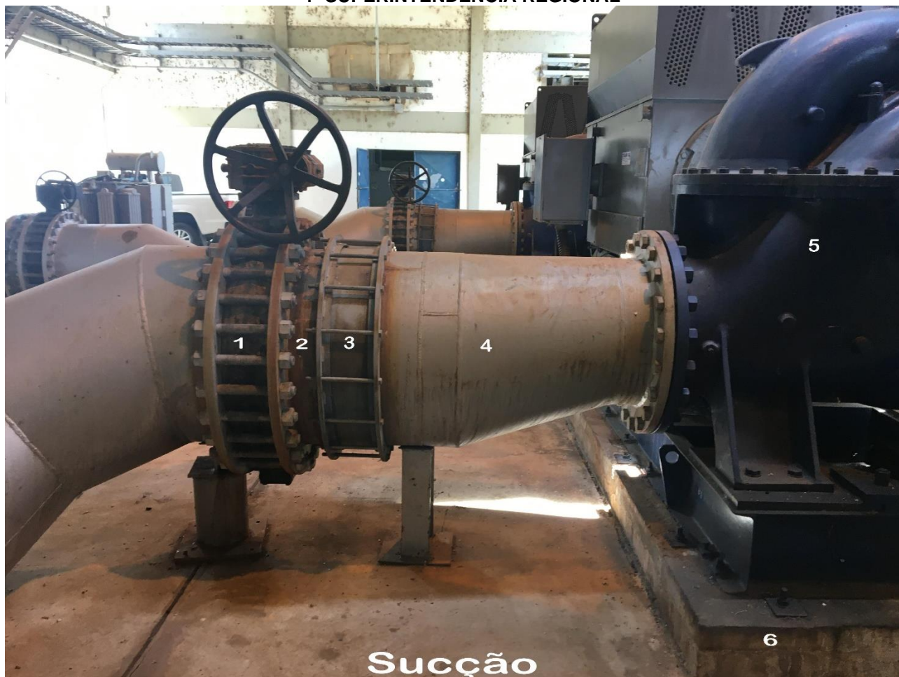
Figura Ilustrativa 01 - tubulação de sucção existente
