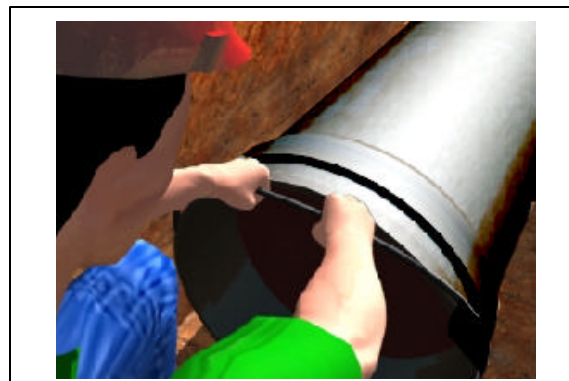
Fig. 07 - Colocação de anel de vedação JE
