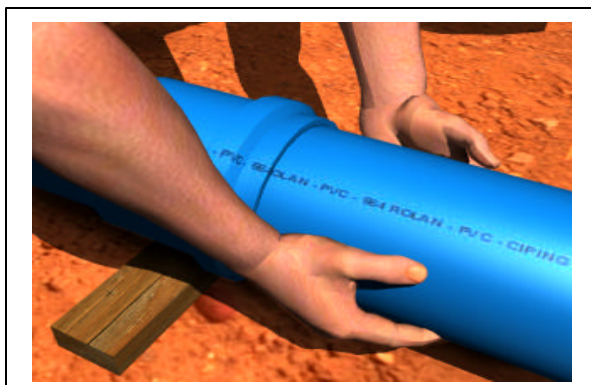
Fig. 04 - Conexão dos tubos
