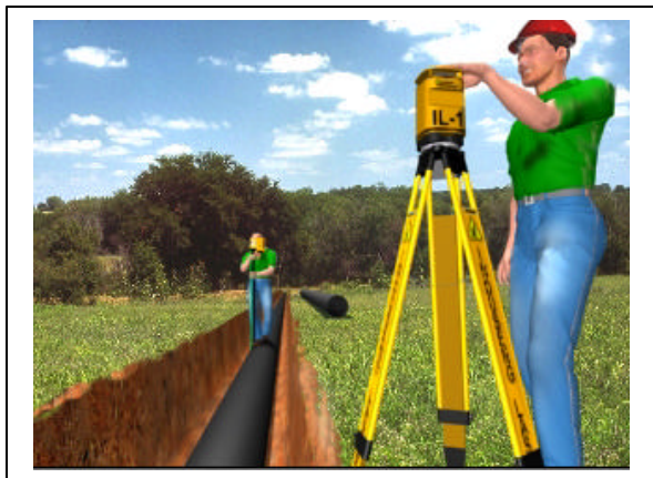
Fig. 04 – Verificação das Cotas
