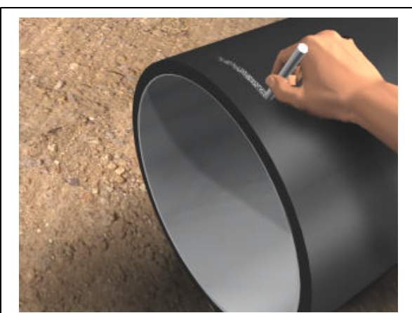
Fig. 05 - Deverá ser feita uma marca, com giz, na ponta do tubo, ...
