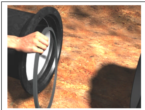
Fig. 03a - Observar o sentido correto do anel de borracha ...
