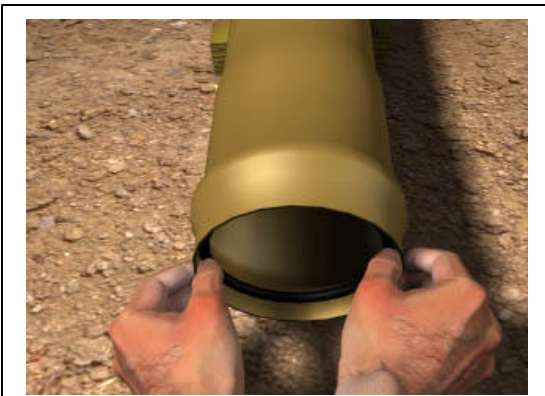
Fig. 02 - Introdução do anel de borracha
