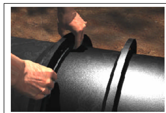
Fig. 05 - Montagem da junta
