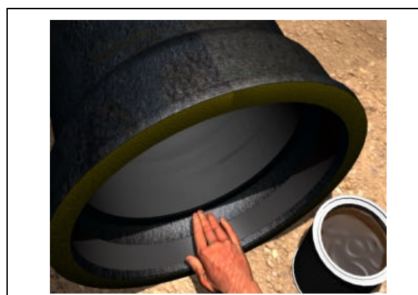
Fig. 07 - Aplicação do lubrificante
