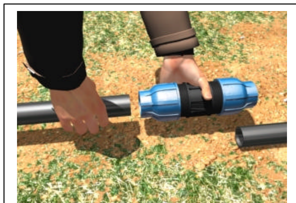
Fig. 45 - O tubo será posicionado e encaixado na bolsa da conexão.
