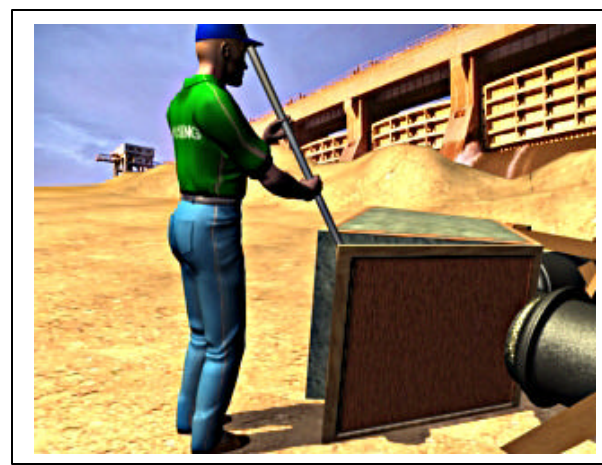
Fig. 05. Desforma do bloco
