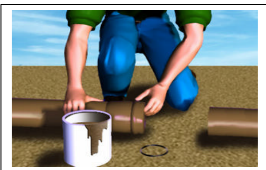
Fig. 03 - Aplicação da pasta lubrificante
