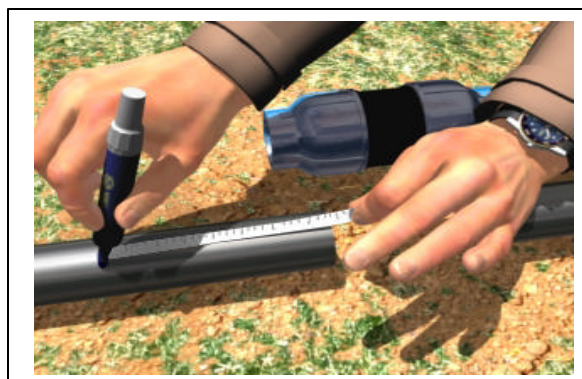
Fig. 43 - Com o auxílio de uma caneta, será marcado nos tubos o valor medido.
