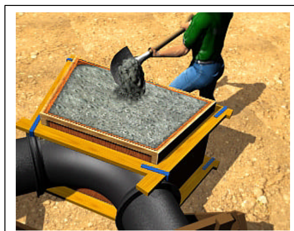
Fig. 04a. Concretagem do bloco
