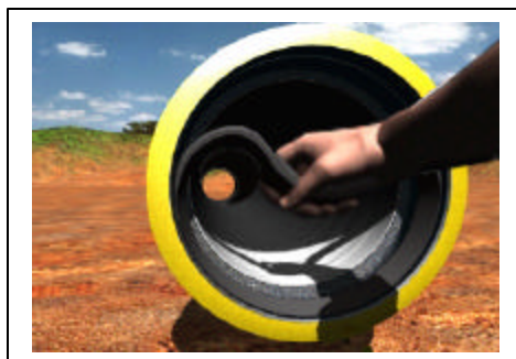
Fig. 02a - Colocação do anel de borracha
