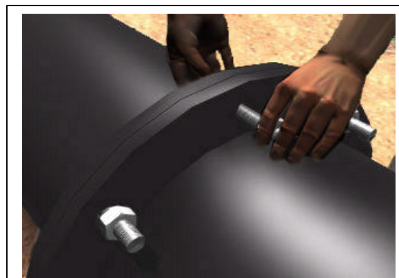
Fig. 06 - Colocação dos parafusos
