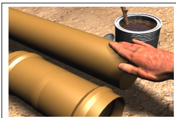
Fig. 10 - Aplicação da pasta lubrificante
