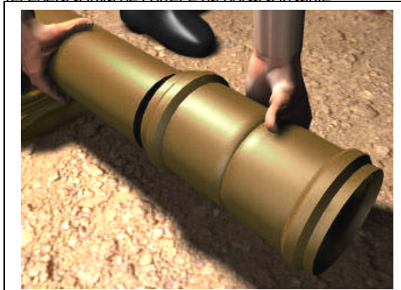
Fig. 11 - Montagem de luva de correr
