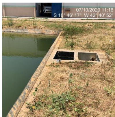
Figura 10: Exemplo de geomembrana de PVC grampeada na parede do tanque de piscicultura, no 2º/CIX (Fonte: Codevasf – 2ª/GRR/UMA).
