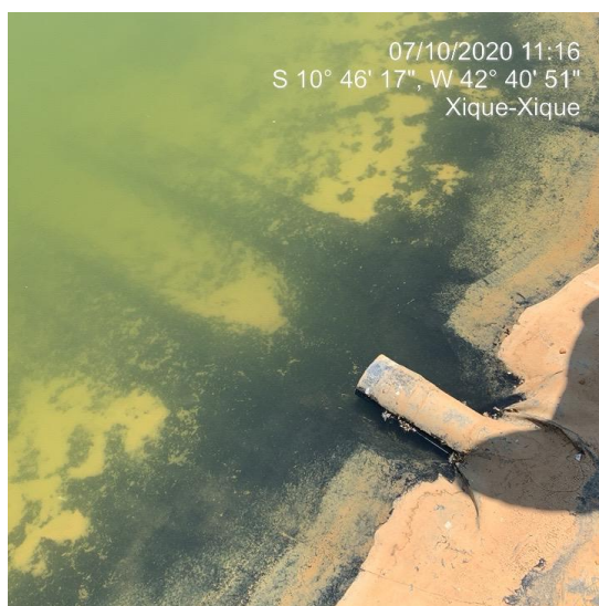
Figura 07: Exemplo de geomembrana de PVC instalada com tubulação de abastecimento (Fonte: Codevasf – 2ª/GRR/UMA).
