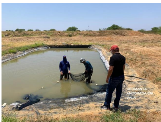
Figura 09: Exemplo de geomembrana de PVC ancorada em vala, no 2º/CIX (Fonte: Codevasf – 2ª/GRR/UMA).
