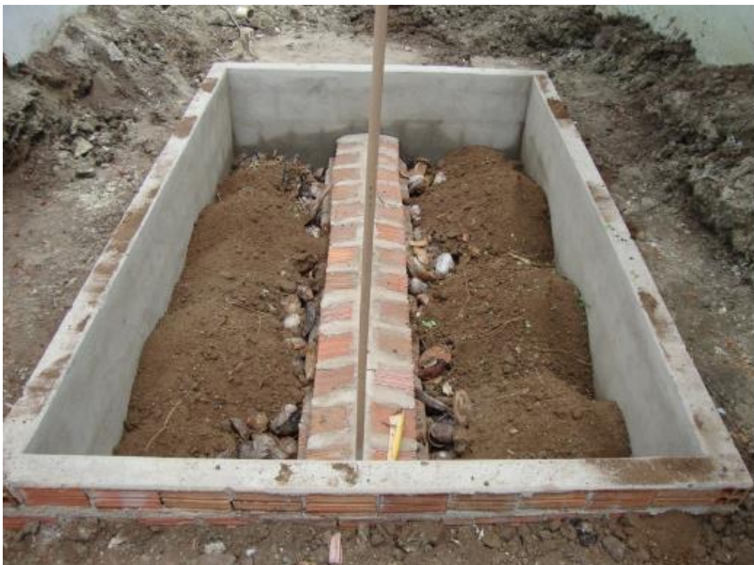
Figura 09: Exemplo de preenchimento de canteiro da fossa séptica de evapotranspiração construída com blocos cerâmicos, mostrando o tubo de suspiro da câmara anaeróbica.
