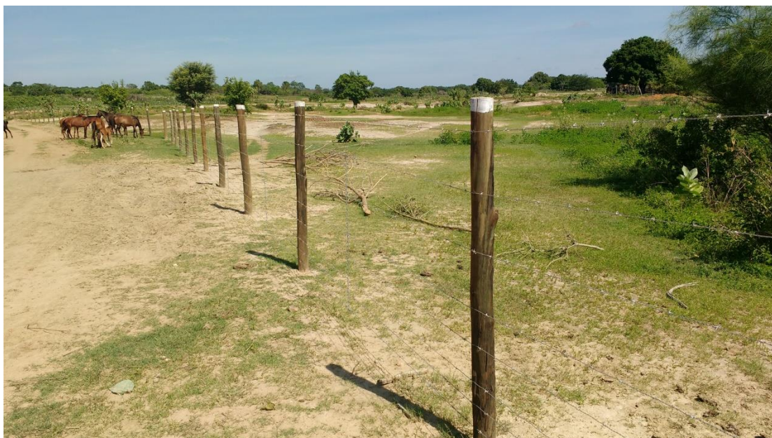
Figura 04: Cerca de arame farpado de 8 fios, com estacas/mourões de eucalipto tratado, espaçados a cada 3,00 m, com balancins de arame zincado, instalada pela Prefeitura Municipal de Mansidão na APP das nascentes do Riacho das Aroeiras.
