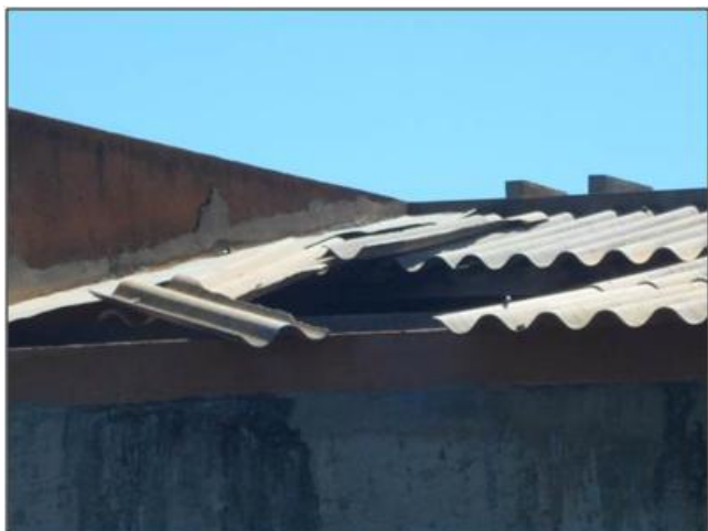
Vista do estado de conservação da cobertura da casa de bomba.
