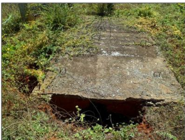
Vista do estado de conservação da estrutura física da fossa do banheiro.
