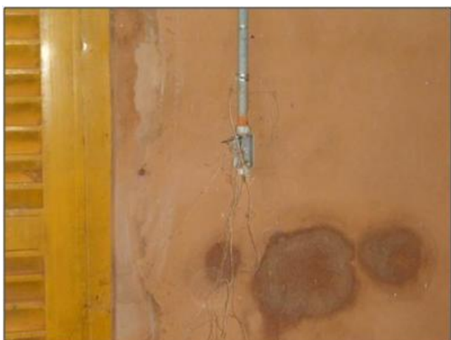
Vista do estado de conservação do interruptor – Casa de bomba.
