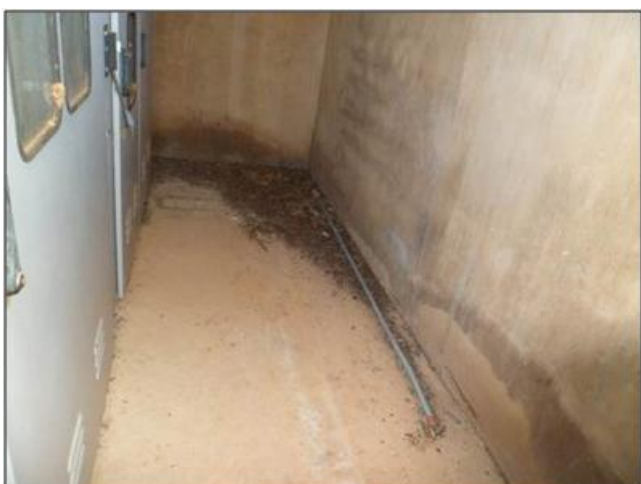
Vista do estado de conservação do piso da subestação elétrica.
