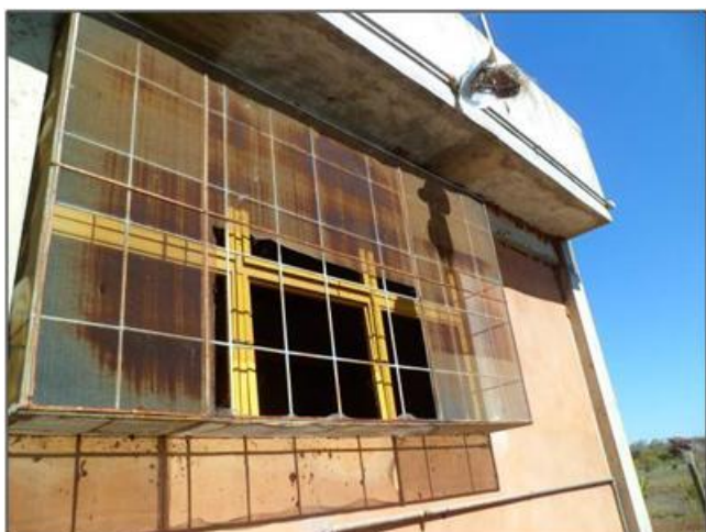
Vista do estado de conservação da tela metálica da janela da casa de bomba.
