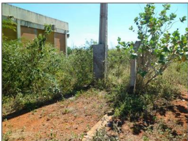
Vista do estado de conservação do pátio de manobra – Ausência de brita.
