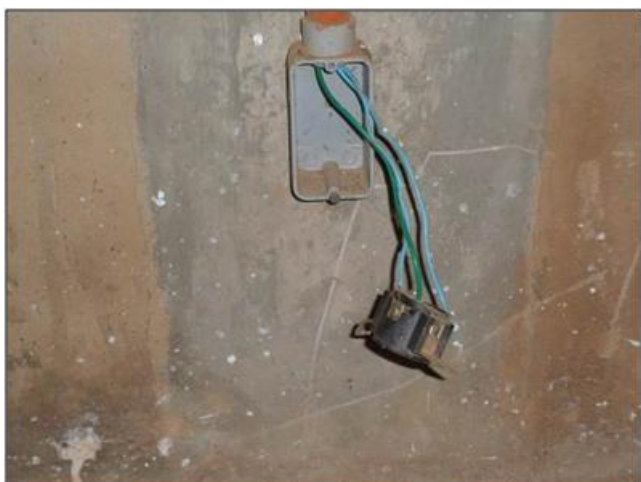
Vista do estado de conservação das tomadas de energia – Casa de bomba.
