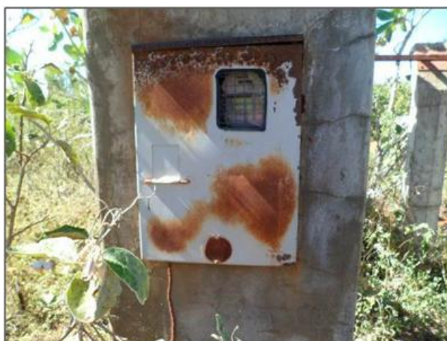
Vista do estado de conservação do medidor de energia da casa de bomba.
