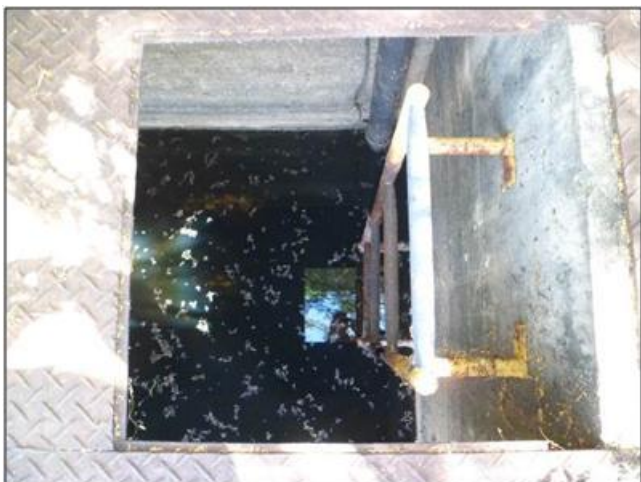
Vista do estado de conservação do poço de sucção da casa de bomba.
