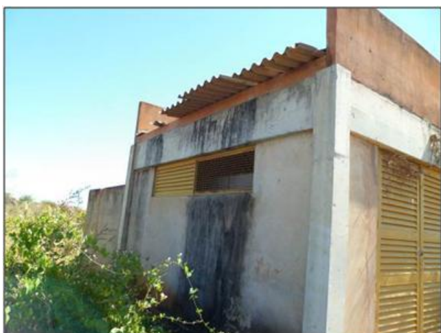
Vista do estado de conservação da cobertura do prédio – Telha de amianto.
