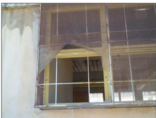
Vista do estado de conservação da janela e da tela metálica da casa de bomba.
