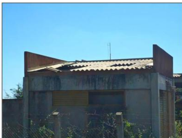
Vista do estado de conservação da cobertura da subestação elétrica.
