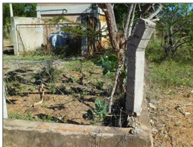
Vista do estado de conservação do cercamento da casa de bomba.
