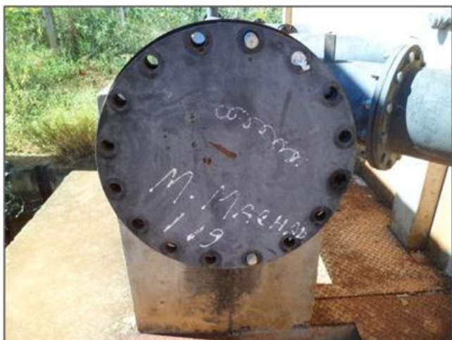
Vista do estado de conservação da tampa de vedação do barrilete.
