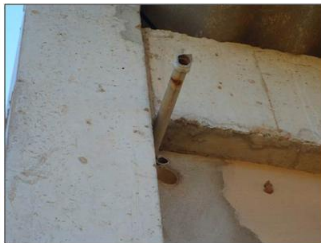
Vista do estado de conservação do conjunto de conexões para o abastecimento de água do banheiro – Casa de bomba.
