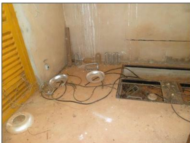
Vista do piso emborrachado e das canaletas para distribuição de energia na casa de bomba – Ausência de tampa de proteção.
