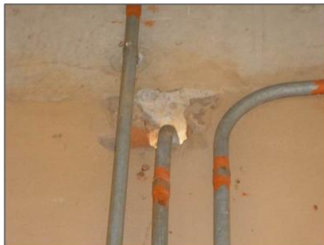
Vista do estado conservação do reboco interno da casa de bomba.
