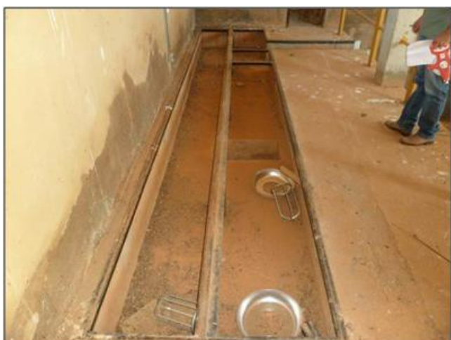
Vista do estado de conservação das canaletas para distribuição de energia na casa de bomba – Ausência de tampa de proteção.
