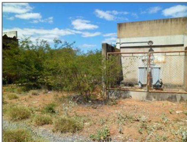
Vista do pátio de manobra da casa de bomba – Ausência de brita.
