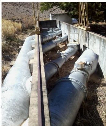
Detalhes da instalação – barrilete de comando.
